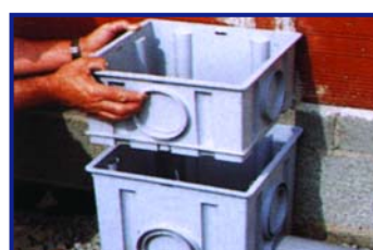
Поставяне на надстройката
